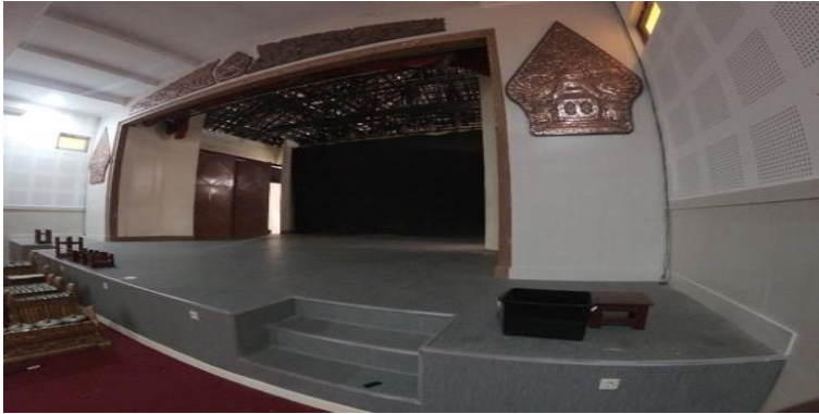
Gambar 18. Penggantian vinyl di panggung Lab Pertunjukan Gedung Ki Nartosabdo lantai 2 setelah direnovasi.
